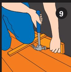
Nach dem Entfernen der Abstandskeile werden die Sockelleisten für einen sauberen Wandabschluss angebracht. An den Übergängen zu anderen Räumen müssen ebenfalls Dehnungsfugen eingebaut werden. Diese werden nach der Verlegung mit entsprechenden Leisten verdeckt.
